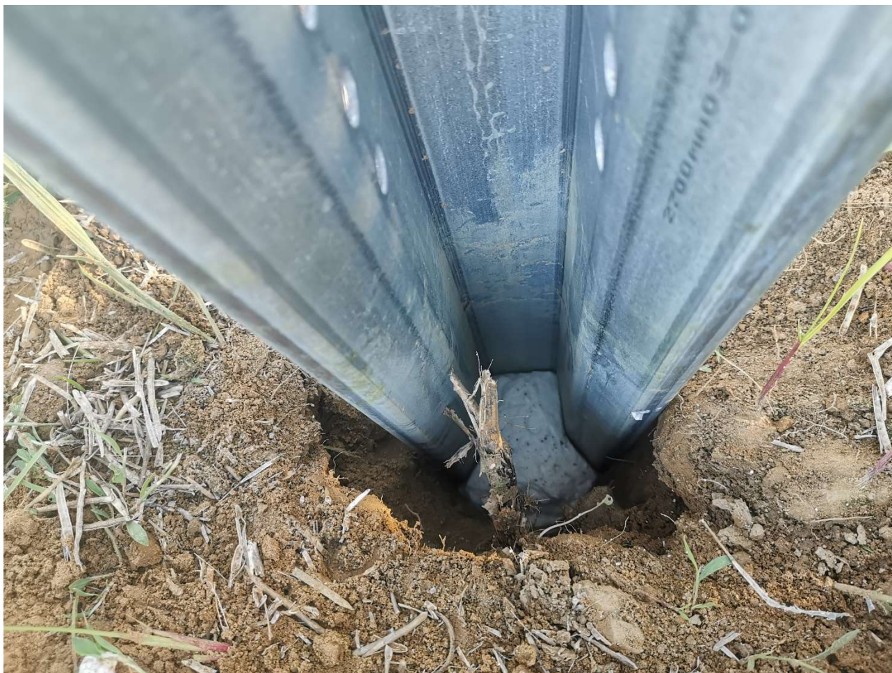
profil ugrađen u PUR pjenu
